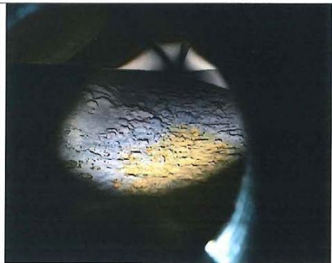
Bild 3 Langkesselsohle mit Korrosionsspuren
