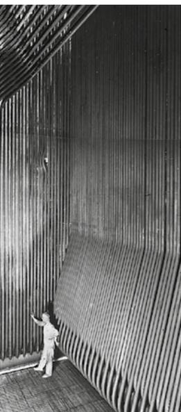
Dans la chambre de combustion d'une chaudière de récupération pour la production d'eau chaude ou de vapeur, la sécurité est vitale.
